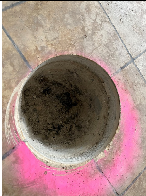
Speerschicht auf Betondecke, Kellergeschoss, Bauteil II, Materialprobe M56
