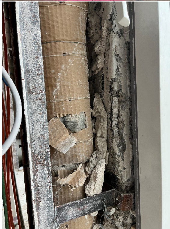
Alte Dämmwolle in Schächten, Stützen Außenwand (innen), Wandputz um Stützen (Sulfat, asbestfrei)
