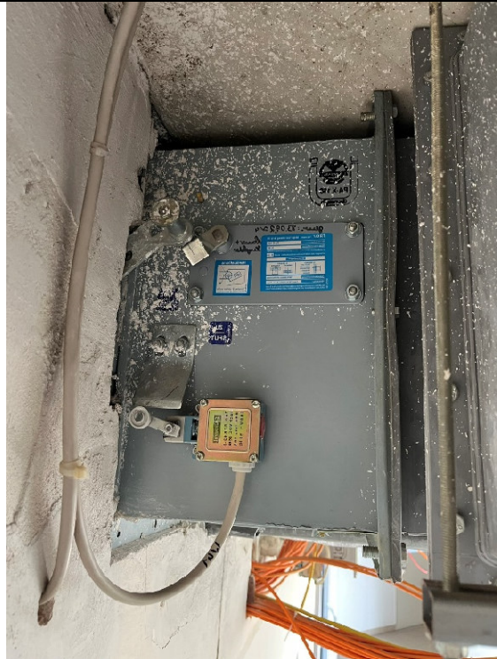
Alte Brandschutzklappen im Gebäude
